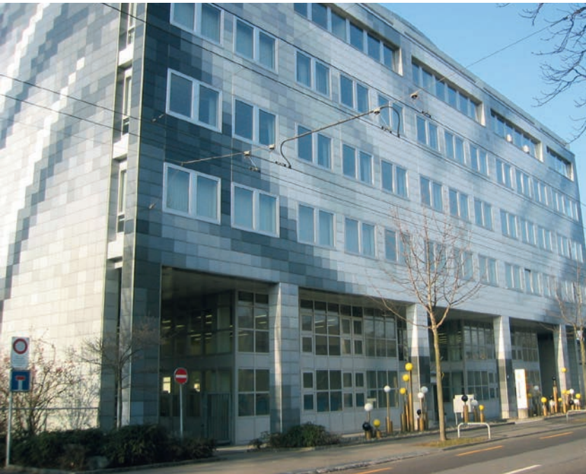
Burkhalter Technics AG, Hohlstrasse 475, Zürich.
