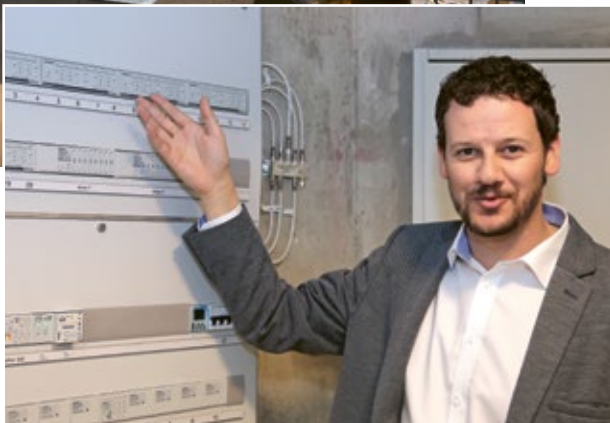
Gabriel Morard kann die Aktoren im Technikraum manuell bedienen.
