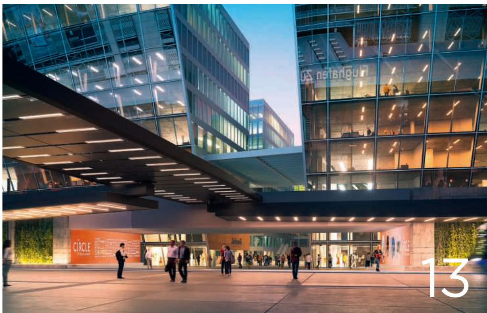
KNX-Vorzeigeprojekt The Circle in Zürich
